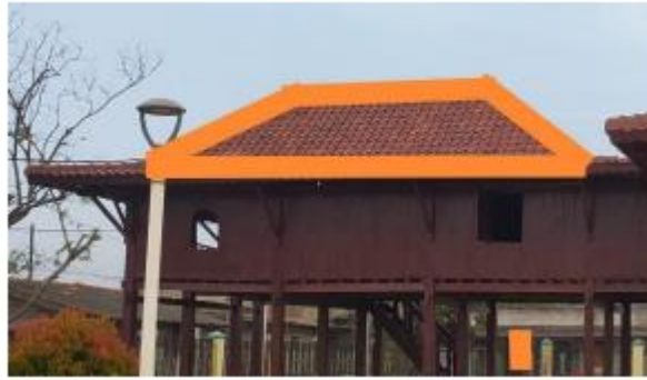
Gambar 5 Atap Bangunan Rumah Adat Betawi Si Pitung yang dapat menunjukkan konsep bangun datar untuk trapesium
